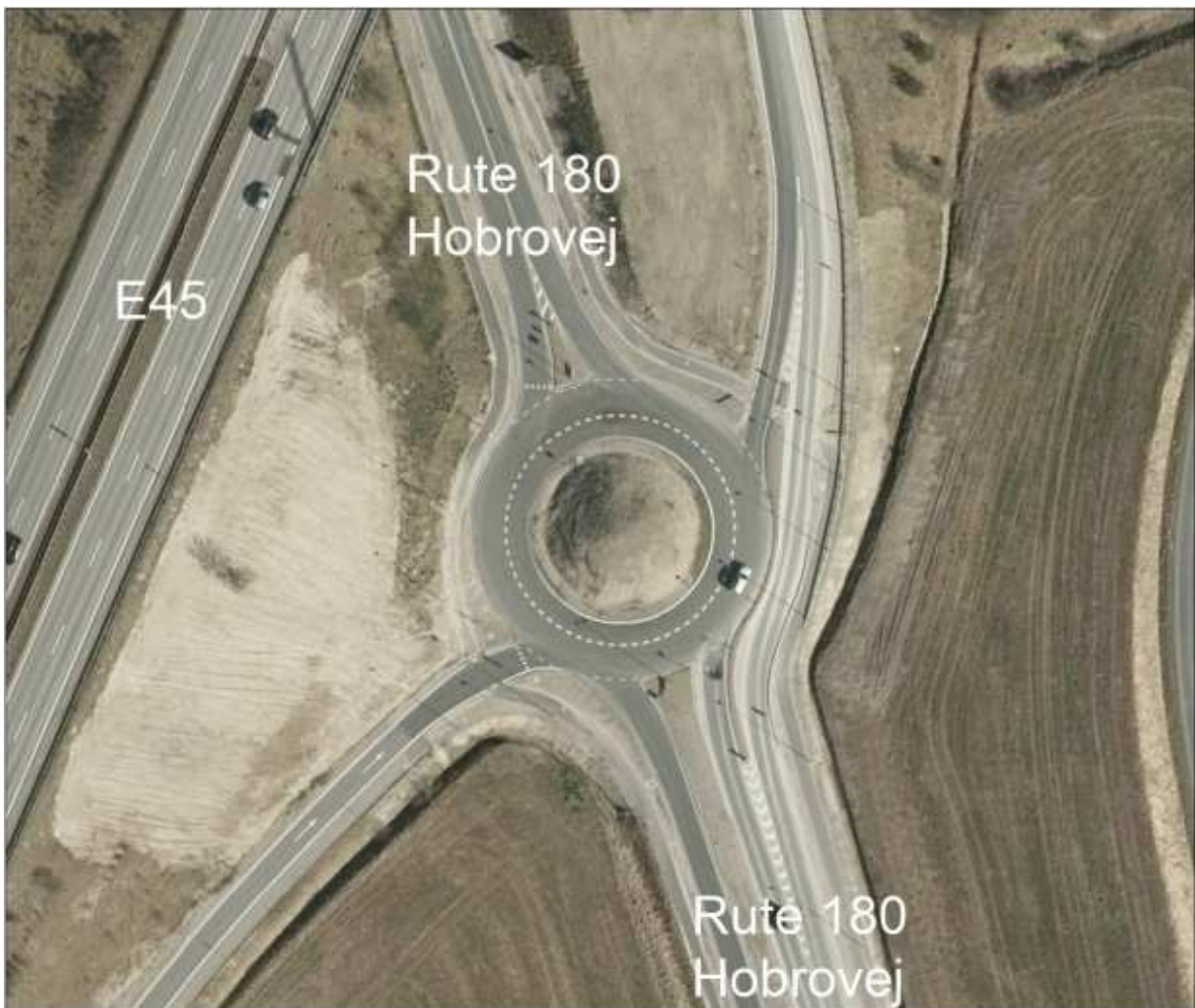
Figur 5: Luftfoto af udført anlæg til forbedring af trafikafvikling på den Nordjyske Motorvej M70 ved Svenstrup.
