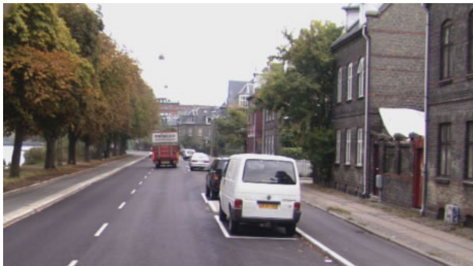
Figur 2. Forsøgsstrækningen på Øster Søgade i København efter udlægning af to-lags drænasfalt.
