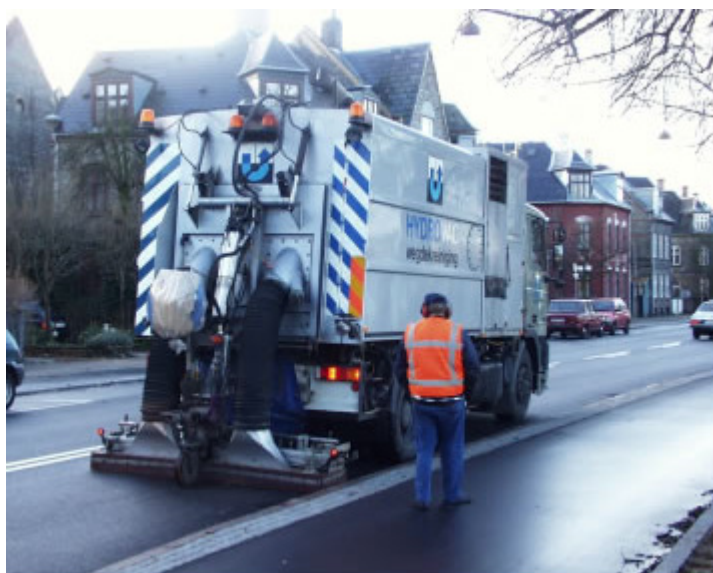
Figur 4. Drænasfalten renses hvert år i april/maj samt november/december med højtryksspuling.
