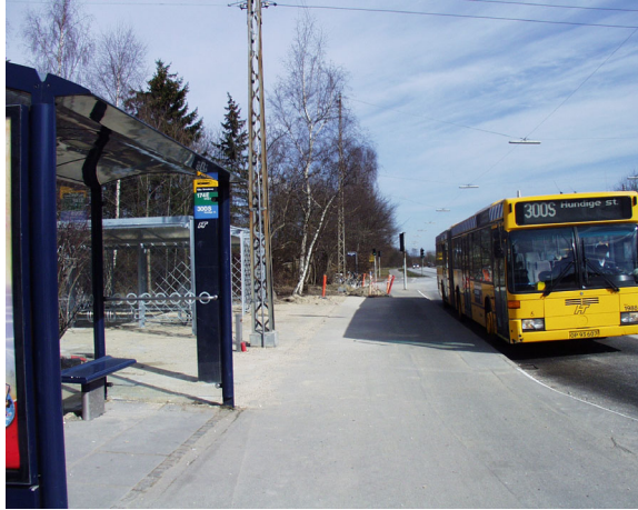
Nordre Ringvej/Mellemtoftevej, sydgående retning Under opførelse, marts 2003
