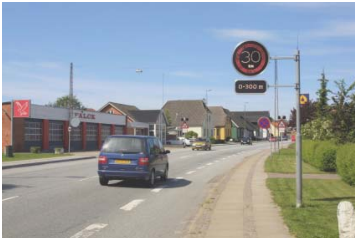
De variable hastighedstavler er suppleret med undertavler med afstandsangivelse 0 - 300 m. km/t. Den 10. april 2002 foretog Rigspolitiets Færdselsafdeling hastighedskontrol på strækningen ved Brovst skole. I den halve time hvor tavlerne var tændt om mor blev i alt fire fartsyndere noteret – hastighedsoverskridelserne lå på mellem 43 og 50. Foto Esben H Thorning.
