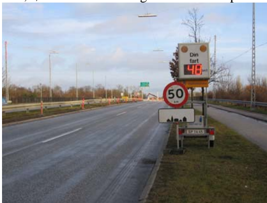
Figur 7 "Din fart" aktiveret - Overskridelse af hastighedsgrænsen medfører gult blink.
