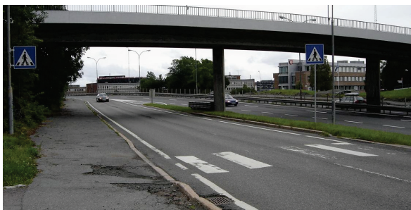
Fodgængerfelt fra Ring 3 til Slemdalsveien. Der er mange bløde trafikanter (over 100 i makstimen), men kriterierne er ikke opfyldt ( V85 = 68 km/t), og der er høj risiko som følge af meget højt hastighedsniveau og to kørespor i samme retning. Anmærkninger til opmærkning og venteareal. Opgraderingen bør omfatte hastighedsdæpende tiltag og indsnævring.
